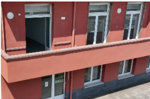
Balcon : reprise structurelle, remise en peinture et création d'une issue de secours à Saverne
